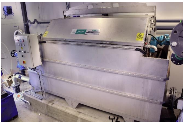
Filtres à disque avec carter inox. Montage en simple
