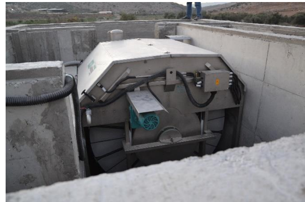
Filtres à disque posés en chenal. Montage simple
